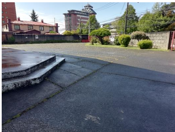
Zona de Seguridad Z4: Acceso Capilla.
