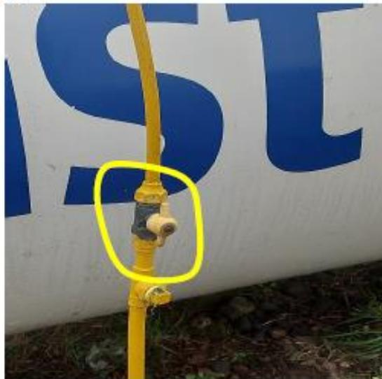
4. Fuera del laboratorio, al costado de la salida de emergencia del quiosco existen 2 cilindros de 45 kg que pertenecen al laboratorio de ciencias. Para el corte de suministro se debe girar la llave que tienen ambos en sentido de las manillas del reloj.
